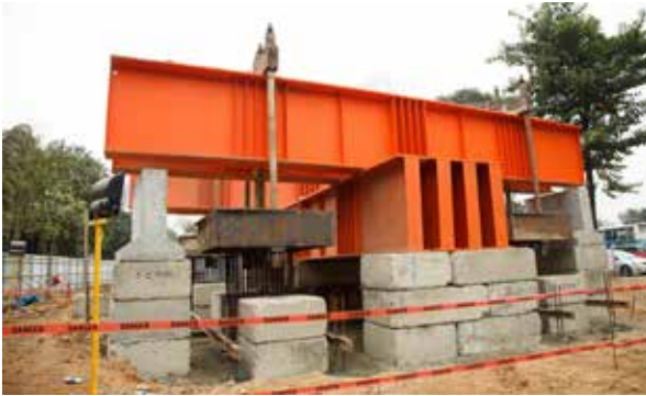
Pile Load test DMRT Line-6, CP-03, 2300 T.
