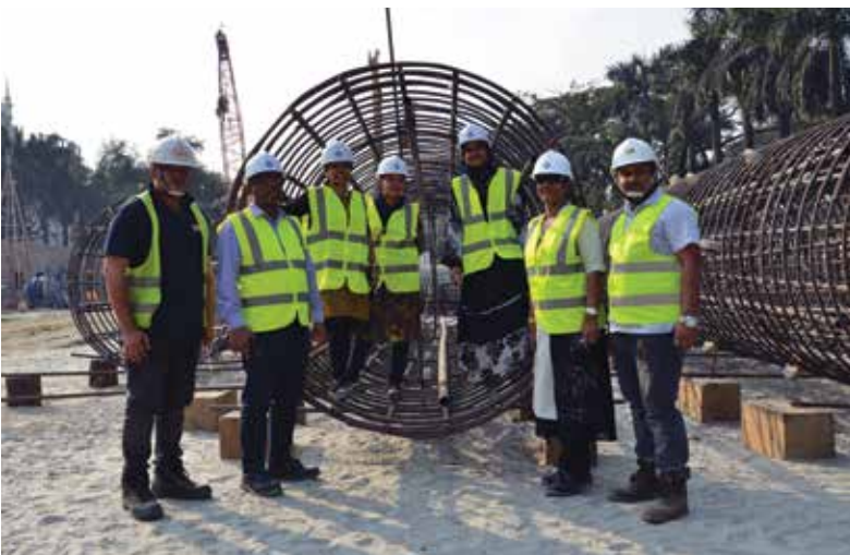
2200 \phi pile Cage.
