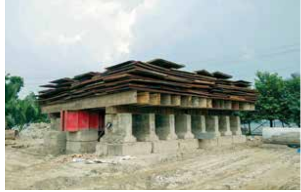
Pile Load test Meghna PVC Ltd. 900 T.
