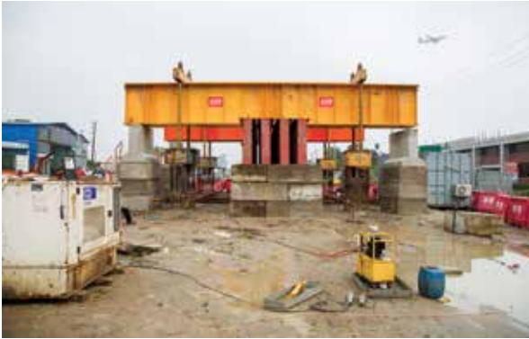
Pile Load test DMRT Line-6, CP-04, 2300 T.
